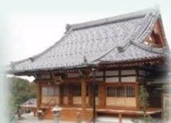
本堂新築工事
