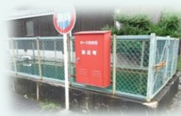
地上防火水槽
